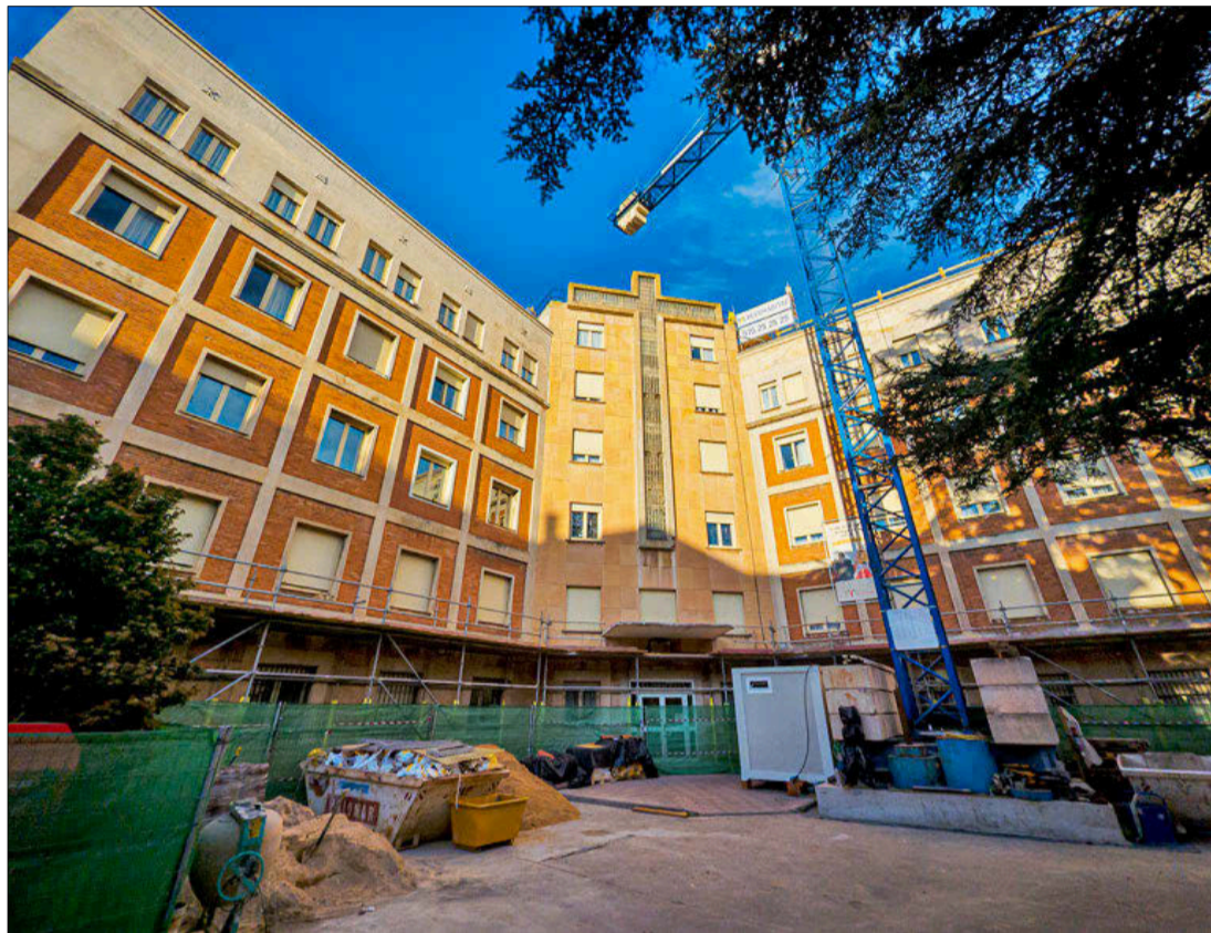
Obras en la Casa Diocesana de Soria. MARIO TEJEDOR
